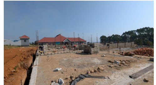
Im Februar 2026 hat die erste Bauphase der geplanten Grundschule begonnen
