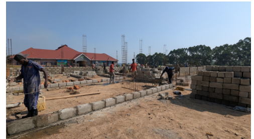
Das Fundament für die neue Grundschule ist gelegt und ermöglicht bald vielen Kindern bessere Zukunftschance
