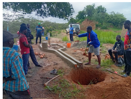
Vorbereitungen für den Bau des geplanten Brunnens in Chiguliro
